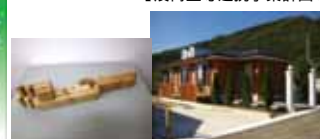
徳島杉の間伐材を利用したつきみ型 ブロック工法による新しい企画住宅の 設計・販売 (徳島県東みよし町)
